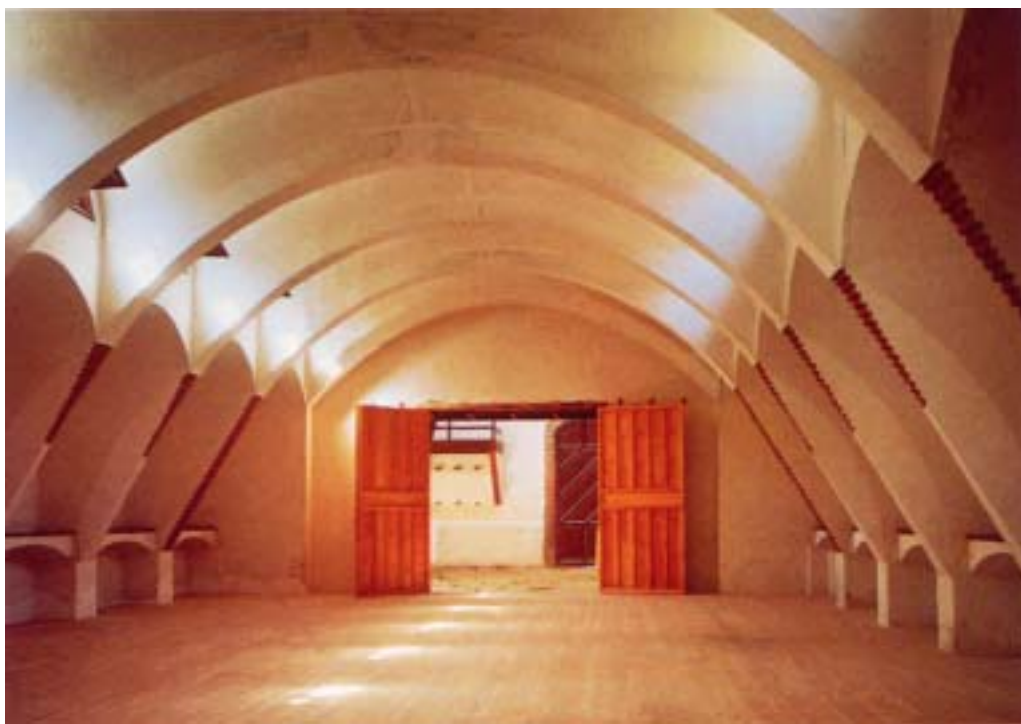
圖七：居艾爾宮・馬廄呈拋物線拱柱 (摘自《高地：創造幻象的建築詩人》，頁 31)
